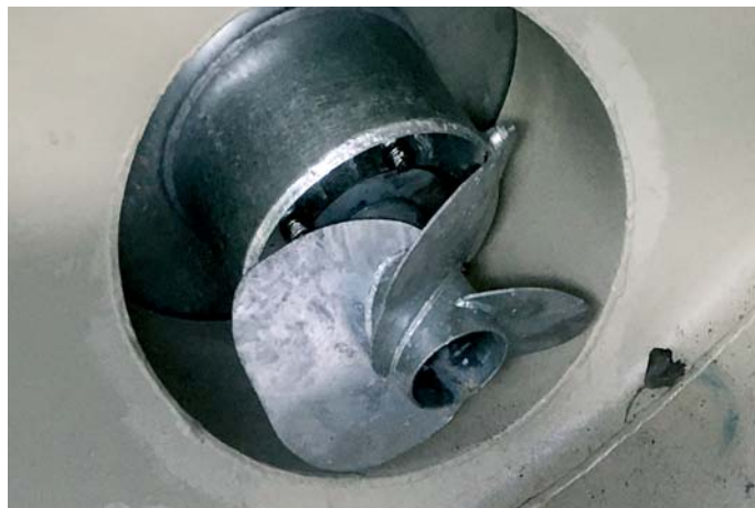
Miešacia vrtuľa v čelnej stene nádrže.
