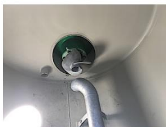
Miešacia vrtuľa je umiestnená v dolnej časti nádrže. Na obrázku je i časť systému vyprázdňovania v kopci.
